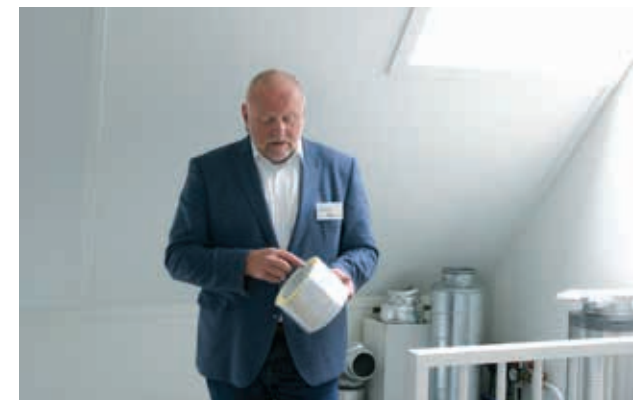
Martin Brouwer van de R-Vent Group legt het nieuwe kanaalsysteem uit.
