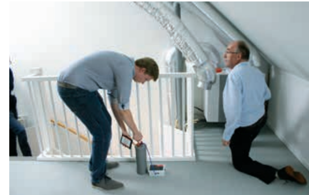
Luchtdichtheidsmeting volgens het nieuwe systeem van Acin.
